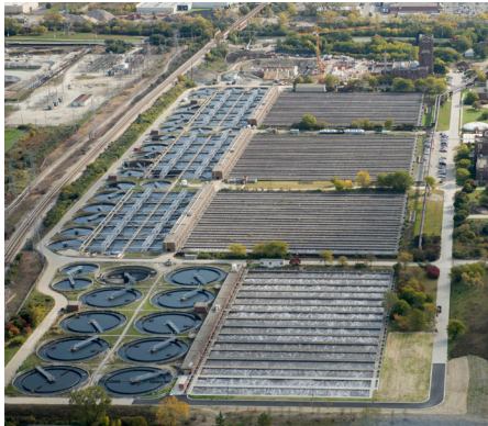
Planta de Tratamiento de Agua O'Brien
