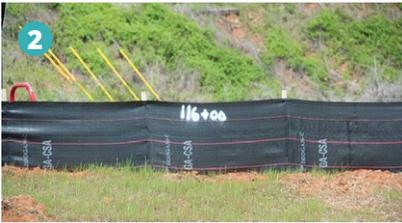
Es crucial prevenir el lavado de sedimentos hacia la zona de construcción para que el sistema final sea exitoso. Instale el cerco para el control de sedimentos (o tubos de paja comprimida) alrededor de esta área,
