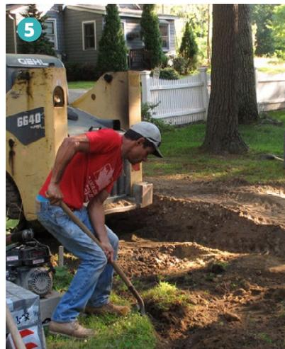
compactación del suelo reducirá o impedirá la absorción de agua de lluvia. Si debe usar maquinaria pesada en la excavación o instalación, colóquela fuera de la zona de construcción.
